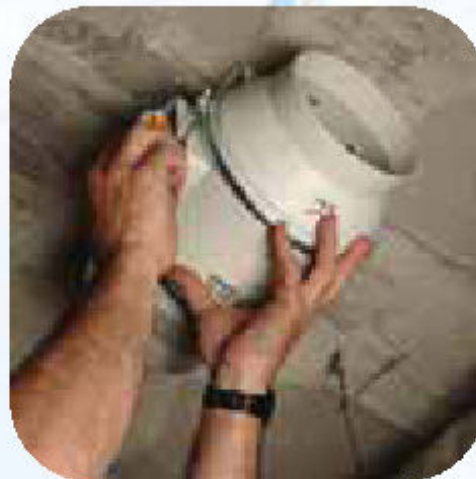
Colocar el cuerpo motor
