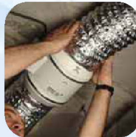
Acoplar los conductos
